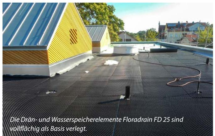
Die Drän- und Wasserspeicherelemente Floradrain FD 25 sind vollflächig als Basis verlegt.
